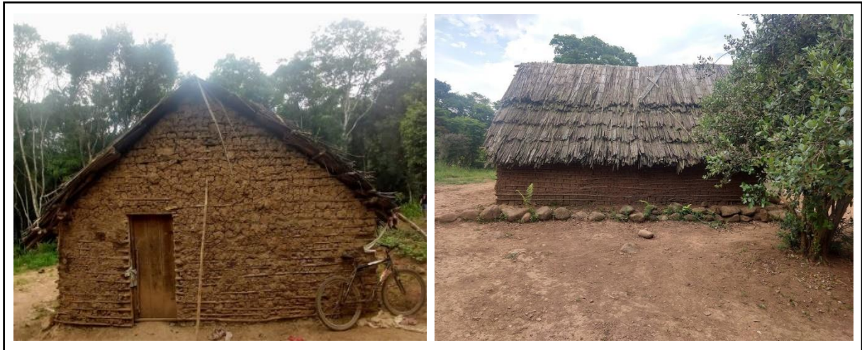
Figura 01: Casa de pau-a-pique Mbyá Guarani - Maquiné – RS. Fonte: Autor (2019). Figura 02: Lateral da Casa de Rezo (Telhado de Taquara Mansa) Mbyá Guarani – Maquiné – RS Fonte: Autor (2019).
