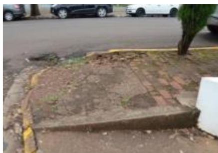
Figura 6 – Problemas de acessibilidade
