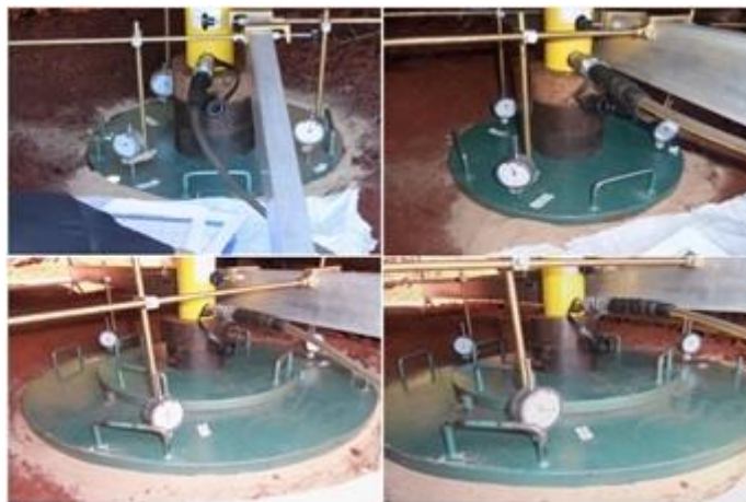
Figura 2 - Instalação dos extensômetros
