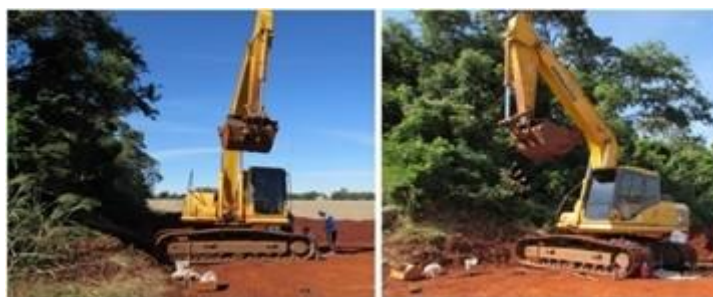
Figura 1 - Escavadeira Hidráulica (sistema de reação)
