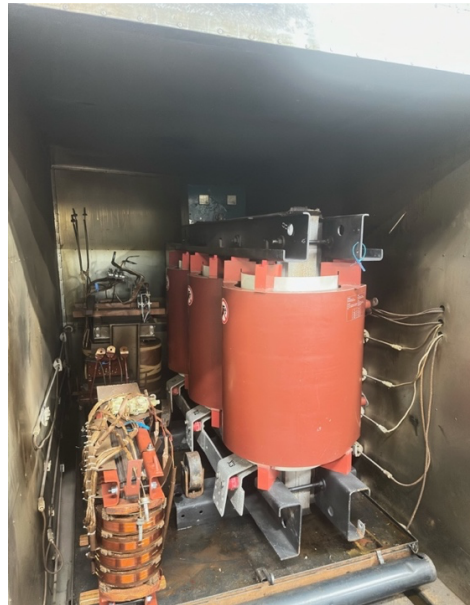
Figura 3: Foto detalhe de uma estufa utilizada para secagem de Transformadores.
