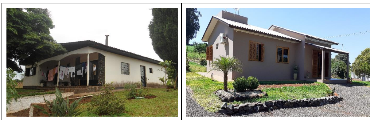
Figura 02 - Residência dos pais e a nova residência
