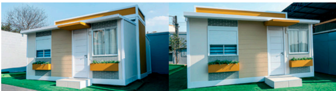
Figura 2 – Unidade habitacional produzida com placas de CPR.
