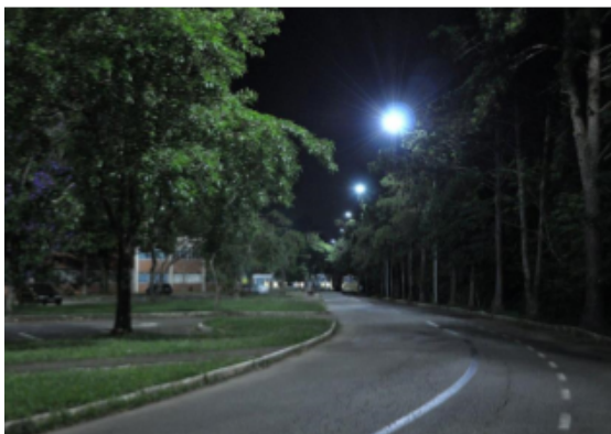
Figura 2 - Foto do trecho após a instalação do sistema LED
