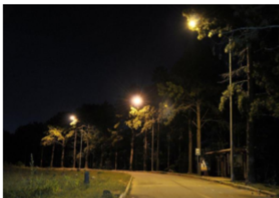
Figura 1 - Foto do trecho antes da instalação do sistema LED
