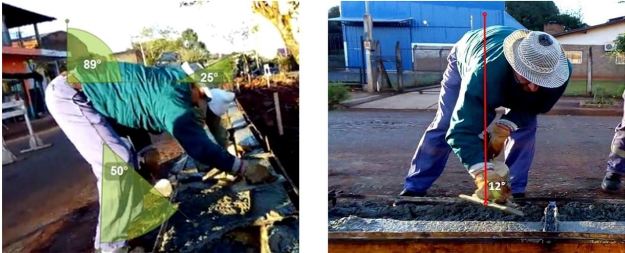
**Figura 2.** Operario en la posición de análisis y ángulos identificados para aplicar el método REBA. Actividad de alisado y terminación
