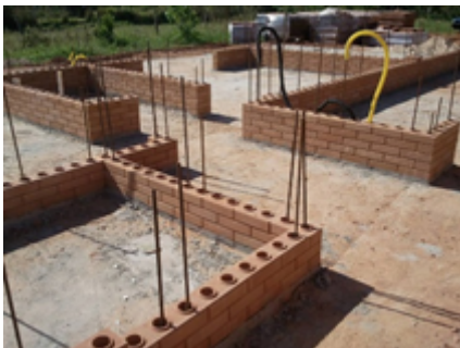
Figura 2: Construção com Tijolo Ecológico - Ferragens dentro dos Furos.
