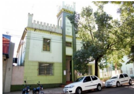
Figura 2: Prédio Tiro de Guerra 337
