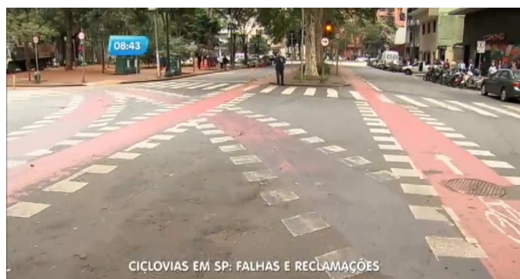
Figura 1 - Intersecção de faixas mal planejadas em São Paulo/SP
