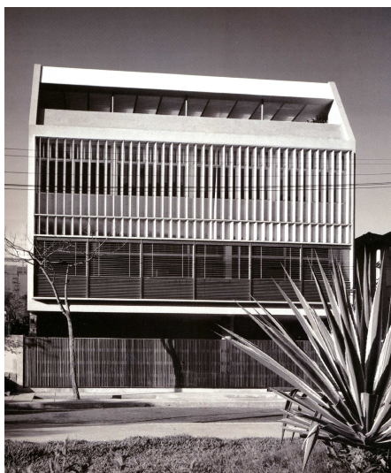
Figura 1 - Residência Antônio Ceppas, Rio de Janeiro, RJ.
