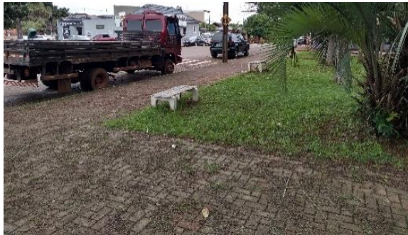
Figura 2: Passeio público a oeste em piso intertravado de concreto
