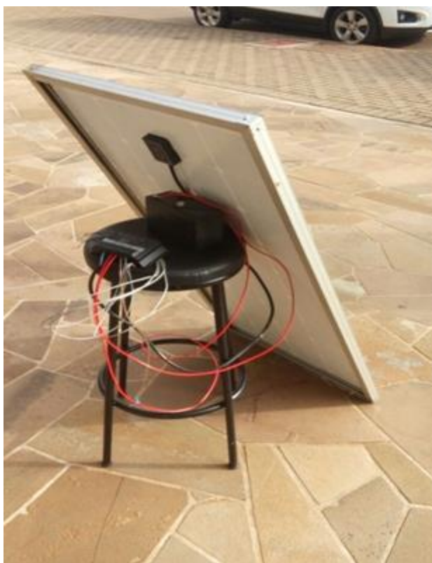
Figura 08: Fiação completa e testada, painel solar já recebendo a energia do sol. Fonte: Própria.
