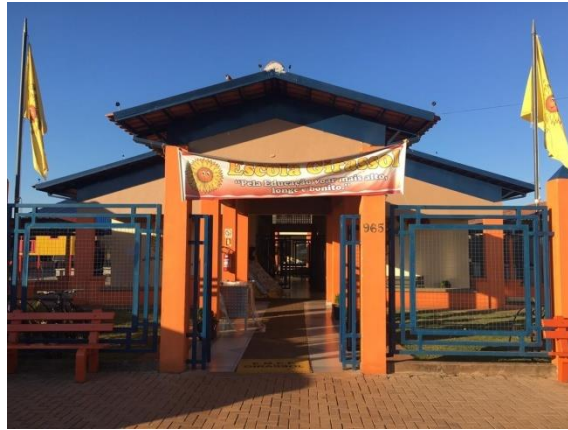
Figura 5: Frente da instalação da nova escola
