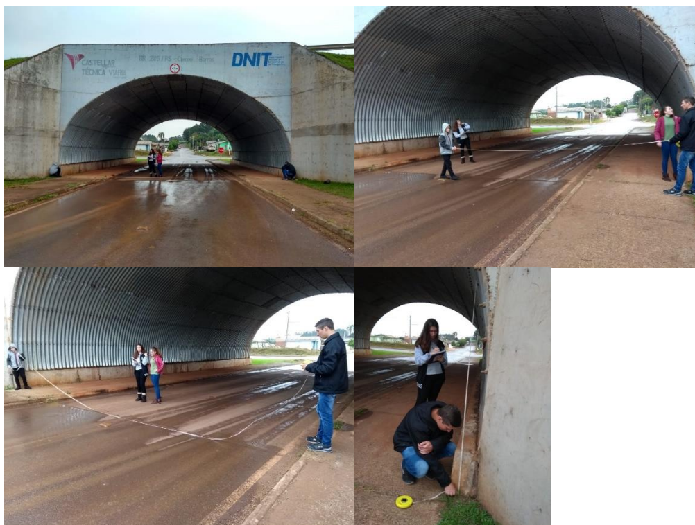
Figura 1- Realização de medições e observação da passagem.
