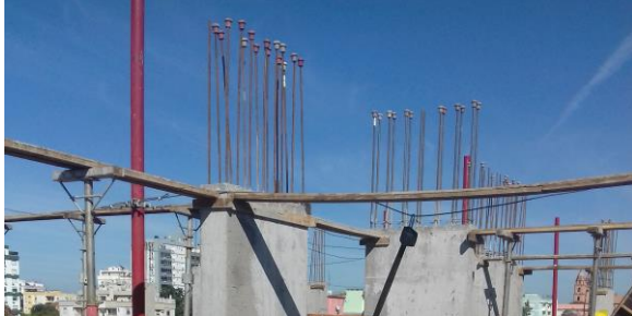
Figura 2. Vergalhões de aço utilizados para proteger a armadura do pilar.
